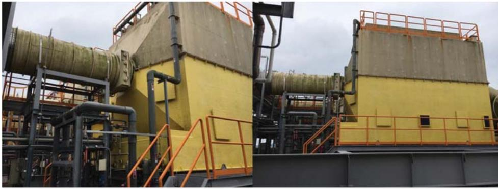
1. 以2" PP皇冠型填充濾材之三生物洗滌塔(每塔填料斷面積4 m×4m，堆填高4.5 m，填充體積72 m<sup>3</sup>，總氣液接觸表面積7,200 m<sup>2</sup>)，處理正常流量為1,800 m<sup>3</sup>/min之晶圓封裝製程排氣。
