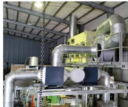
靜電集油機、送風機、次氯酸噴霧接觸槽
